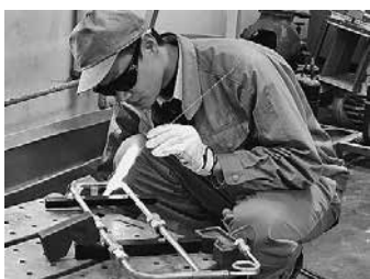
設備工業科：空調設備試験
